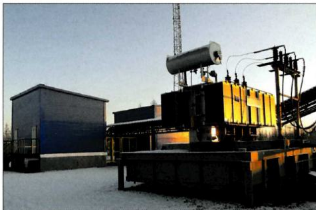
Рис. 4. Источник реактивной мощности на базе УШРТ типа РТМУ-10000/35-УХЛ1 (ПС Ванкор, 2011 г.)
